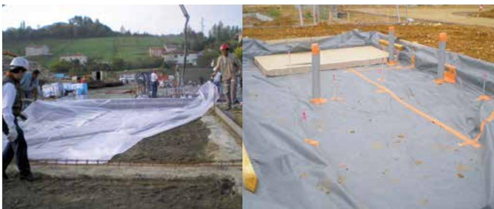
**Il est important que le film polyéthylène soit de 150 $\mu$  et non de type 150 et ce pour les films N°1 et N°2, ainsi que les protections des gaines et canalisations**
