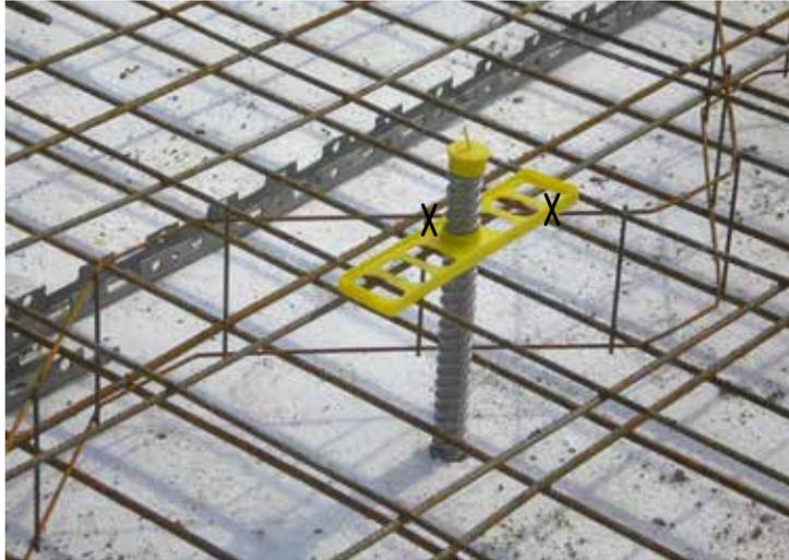
Tube inox à spire hélicoïdale destiné au contrôle du mouillage.
