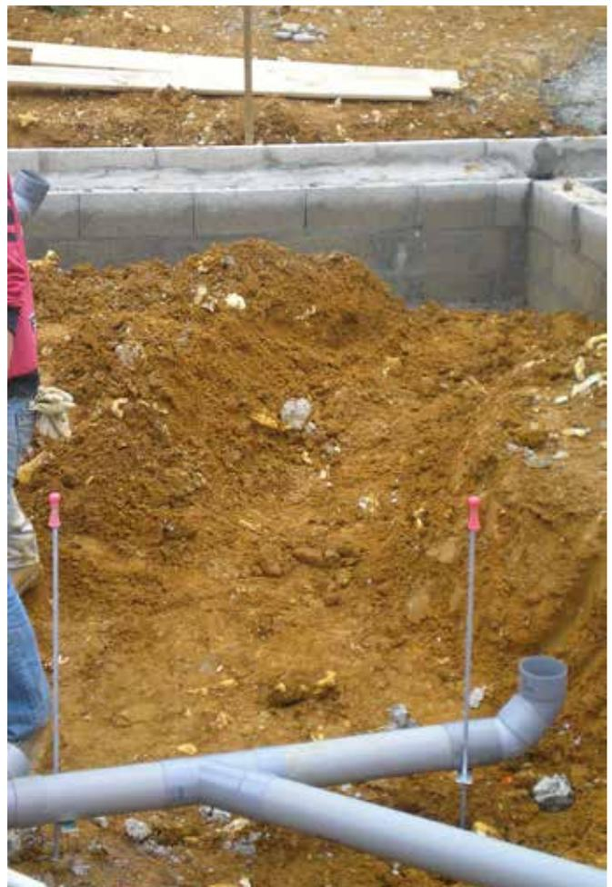
Mise en place des canalisations sur les Firos avant la mise en place de la mousse
