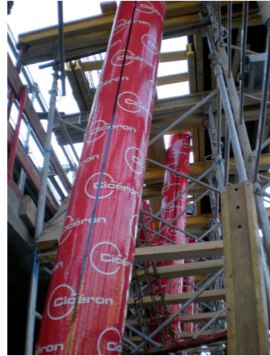
Gamme Cicéron : coulage de poteaux à section ronde
